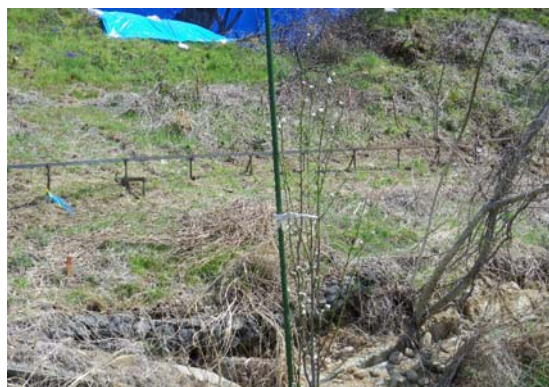
写3-9 のり面のハラミ・盤ぶくれの例
