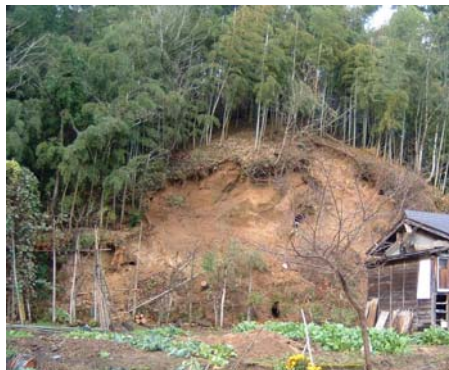
写 3-10 のり面のガリー浸食の例
