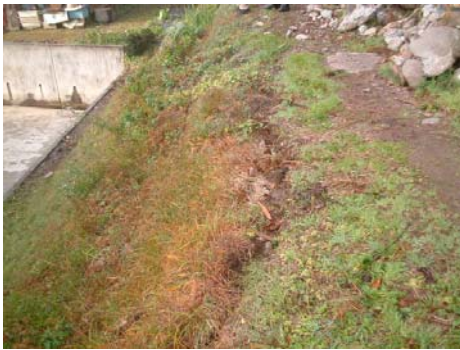
写3-8 のり面のクラックの例
