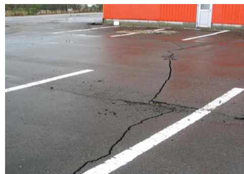
写3-2 宅地地盤のクラックの例
