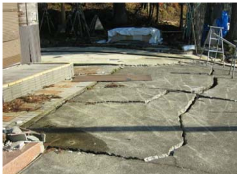
写3-2 宅地地盤のクラックの例
