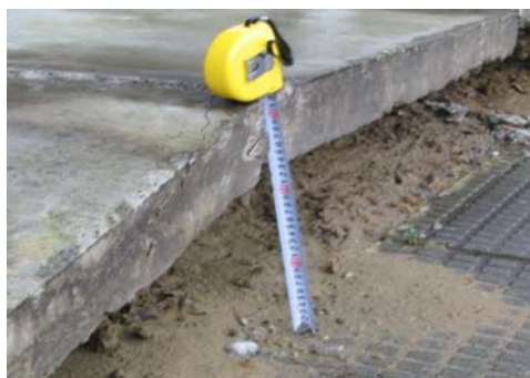
写 3-5 宅地地盤の段差の例
