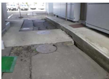
写 3-4 宅地地盤の沈下の例
