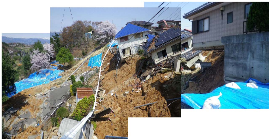
写 3-11 のり面の崩壊の例
