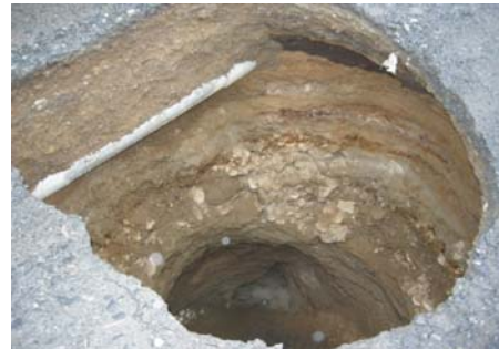
写 3-3 宅地地盤の陥没の例
