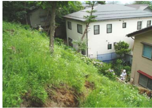
写3-8 のり面のクラックの例
