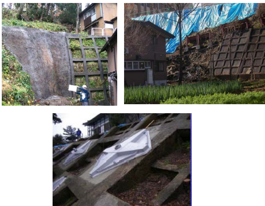
写 3-12 のり面保護工の変状の例
