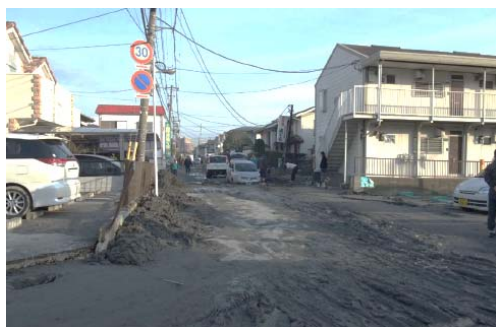
(a) 液状化の被害
