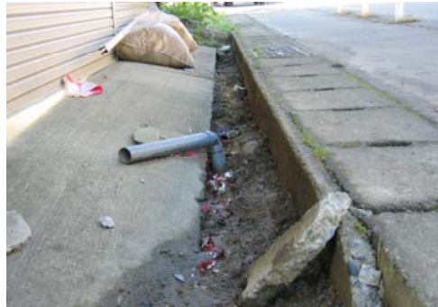
写 3-5 宅地地盤の段差の例
