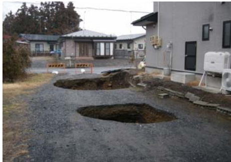
写 3-3 宅地地盤の陥没の例
