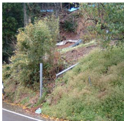
写3-9 のり面のハラミ・盤ぶくれの例
