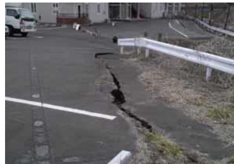
(b)のり肩の亀裂
