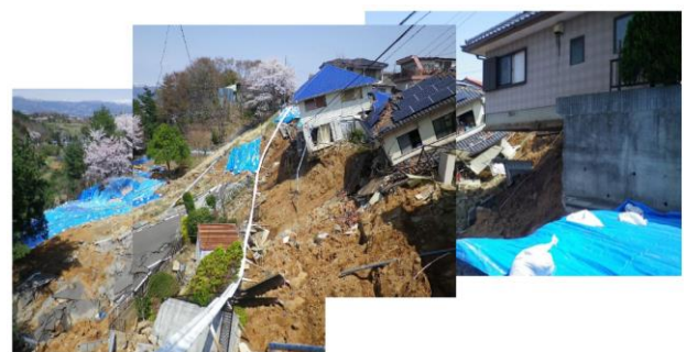
(d)液状化による側方流動
