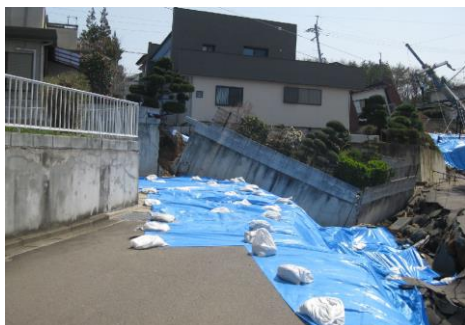
(c)腹付け盛土の崩壊
