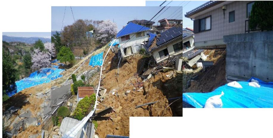
写 3-11 のり面の崩壊の例
