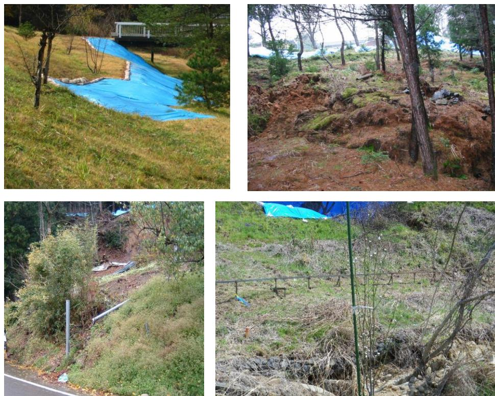
写3-9 のり面のハラミ・盤ぶくれの例
